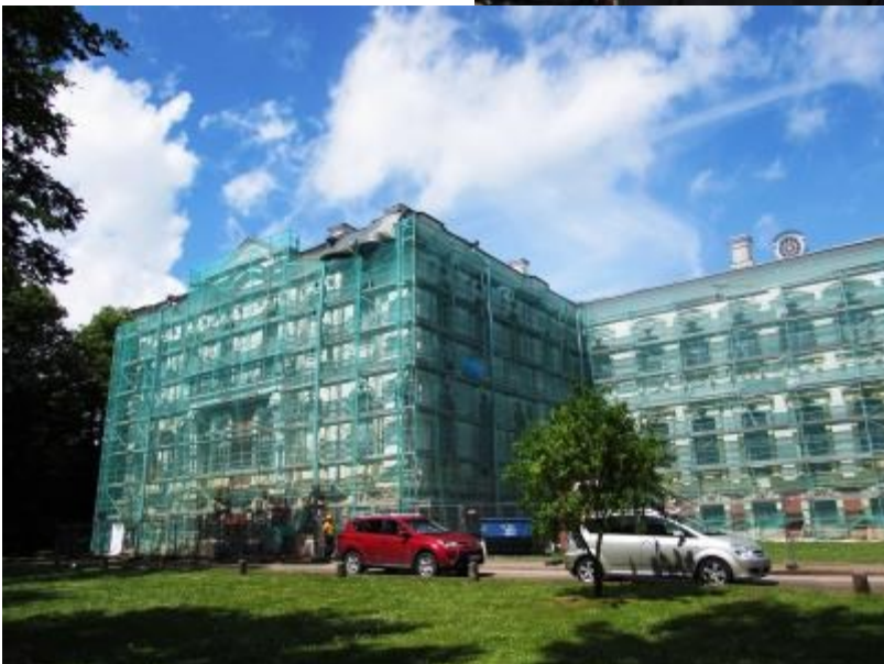
Das Schloss erhält eine neue Fassade.
