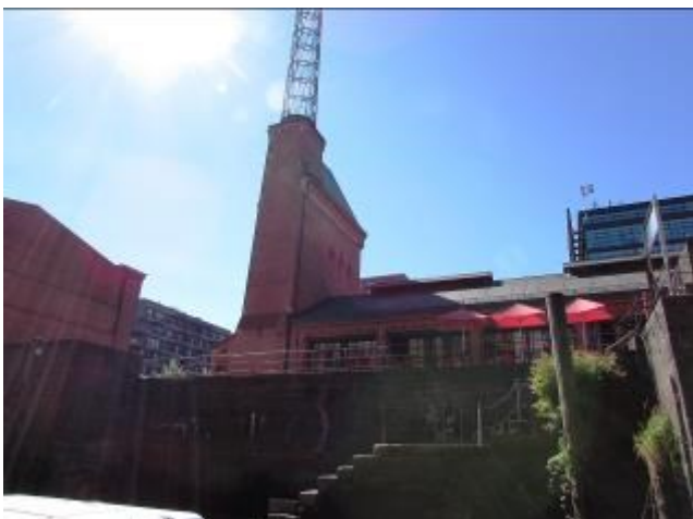
Hier wurde der Dampf für die Aufzüge erzeugt.
